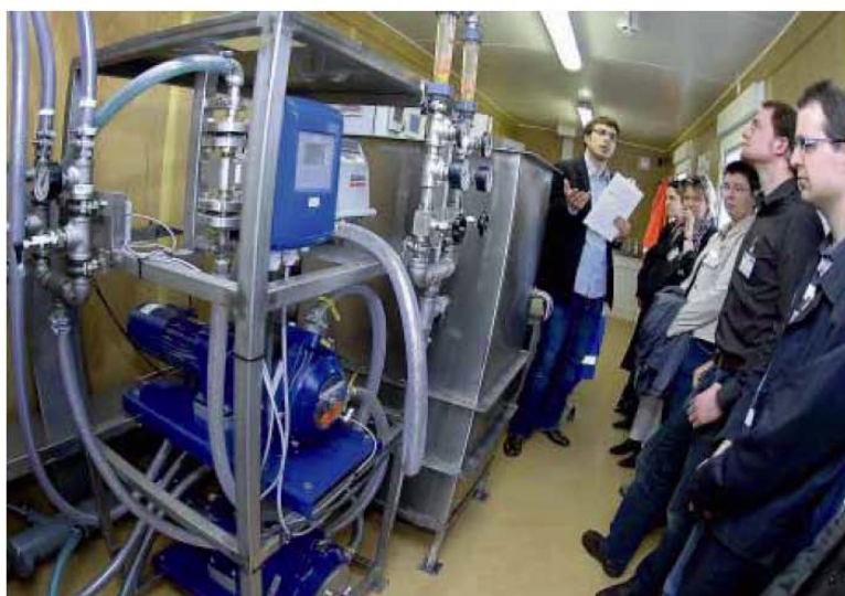
L'installation-test traite aujourd'hui 3 m 3 d'eaux usées par jour.
